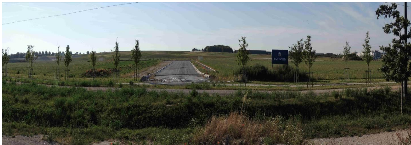
P3 : Vue du site et une partie des voiries internes d'ores et déjà réalisées
